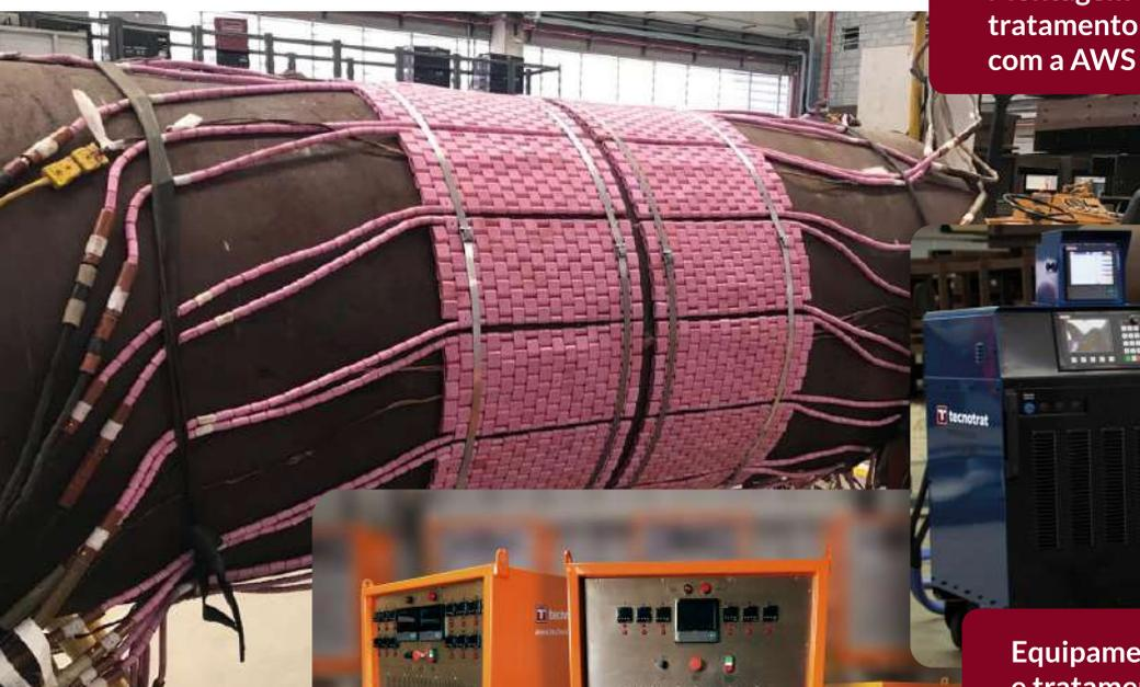
Montagem de resistências para tratamento térmico de acordo com a AWS D10.10
