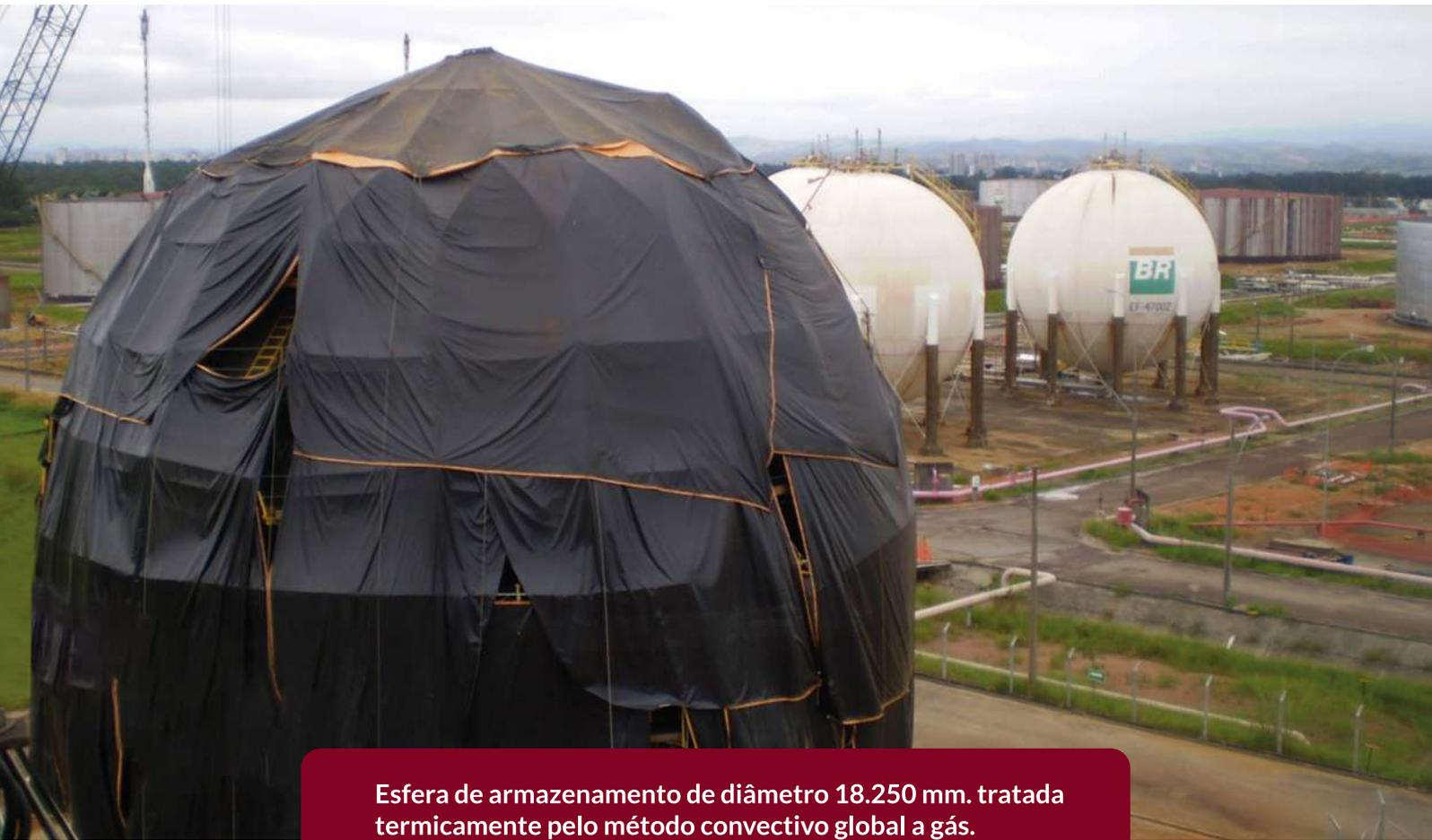
Esfera de armazenamento de diâmetro 18.250 mm. tratada termicamente pelo método convectivo global a gás.
