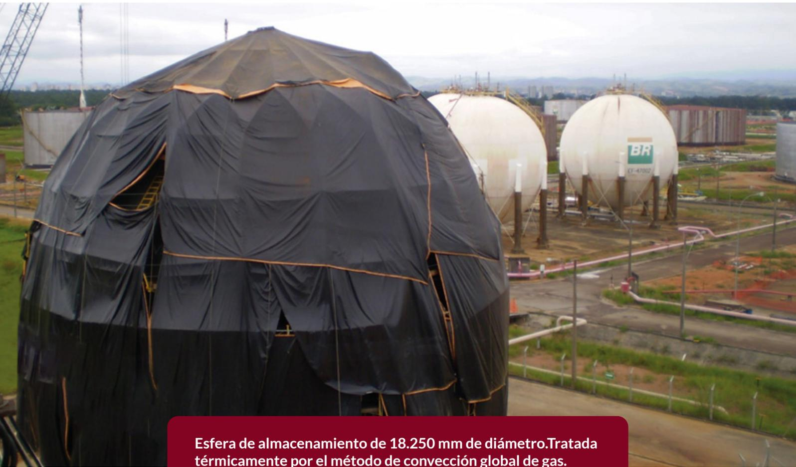
**Esfera de almacenamiento de 18.250 mm de diámetro. Tratada térmicamente por el método de convección global de gas.**
