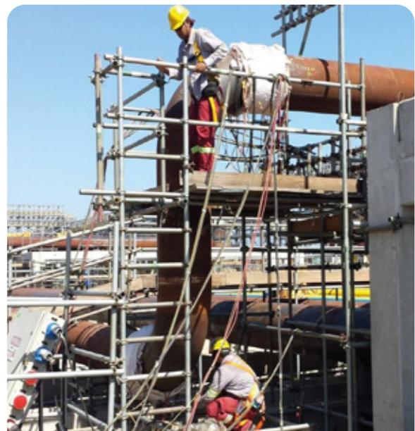
Tratamiento térmico de alivio de tensiones localizado por resistencias eléctricas en soldaduras de tuberías con diámetro de 30" y espesor de 44 mm
