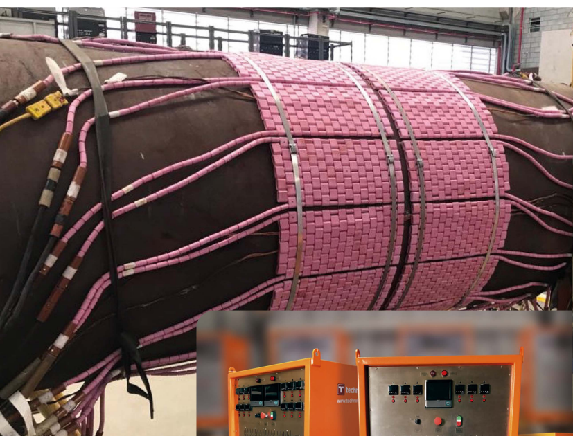
Montagem de resistências para tratamento térmico de acordo com a AWS D10.10
